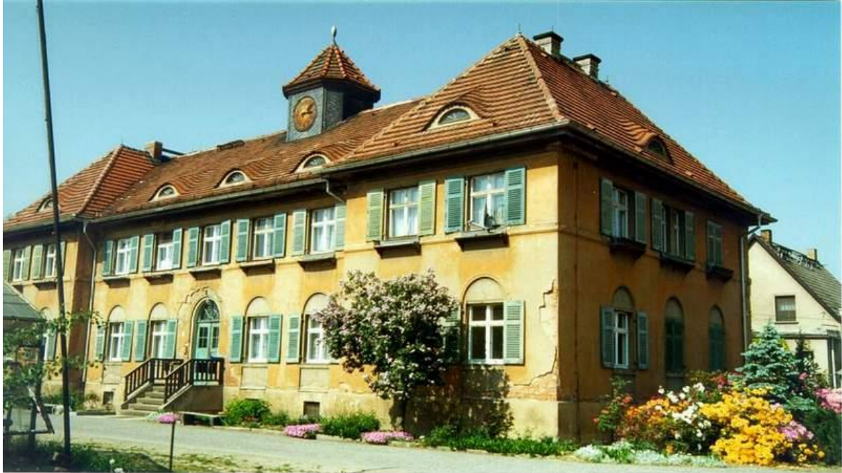
Der Steffen bau auf dem Gelände der überhetr. Ausbildung Foto: Klaus Andre
