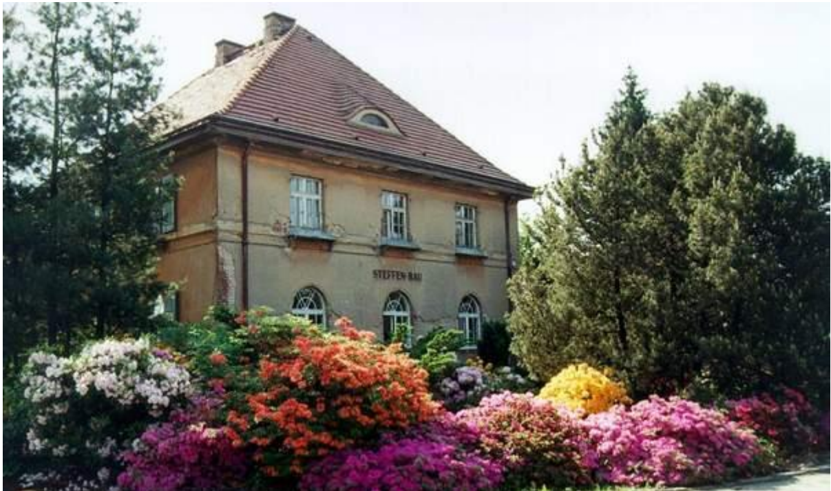
Blick auf das ehemalige Gehilfenhaus im Mai 1998 Foto: Klaus Andre
