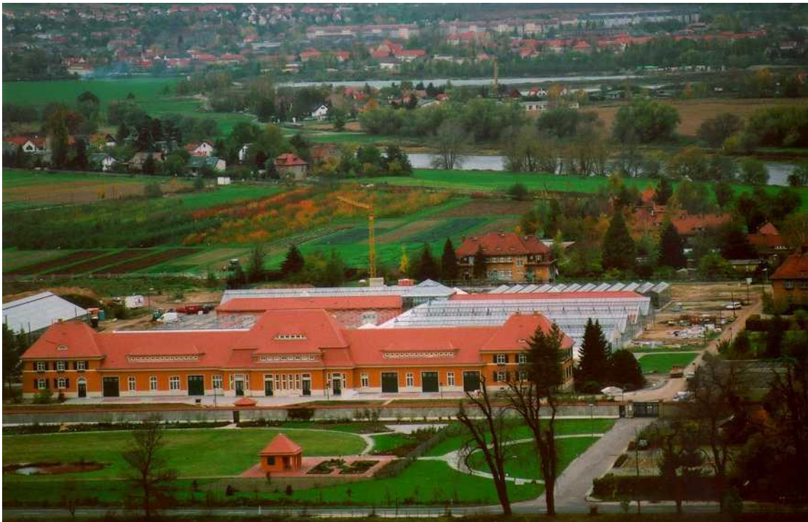
neugestaltetes Nordfeld, rekonstruierter Steffenbau mit der neuen Gewächshausanlage
