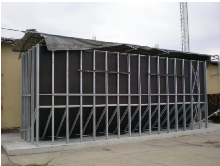
Bild 3: Behälter zur Kohlelagerung
