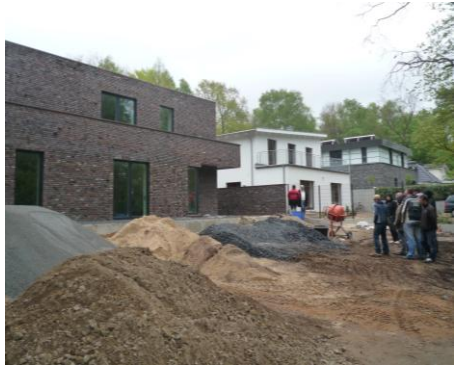
Baustelle an einer neuen Villa in Hamburg-Blankenese
