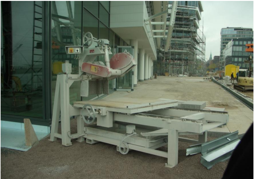
Spezialanfertigung einer Schneidemaschine der Wiese und Suhr Garten- und Landschaftsbau GmbH zum Schneiden der zahlreichen Steinplatten
