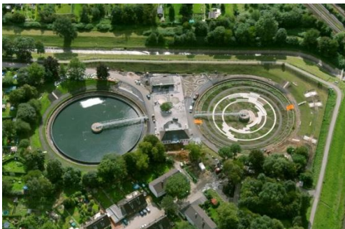
Das Projekt Bernepark während der Bauphase (Quelle: Hans Blosssey, Hamm)
