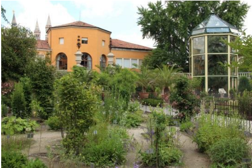
Schutzhaus der „Goethe-Palme“ nach der Sanierung. Foto: Scherzer
