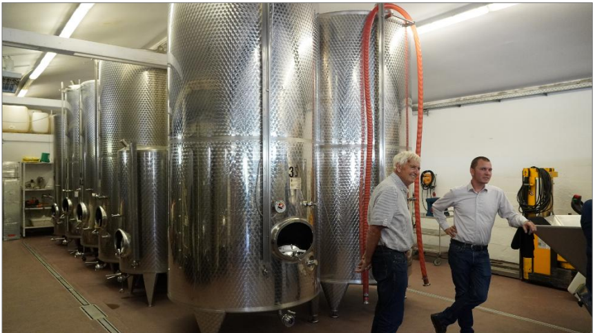
Moderne Stahl tanks prägen den Keller
